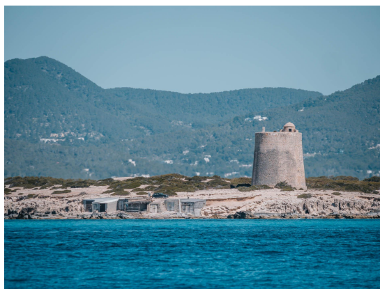
Torre de Ses Portes
